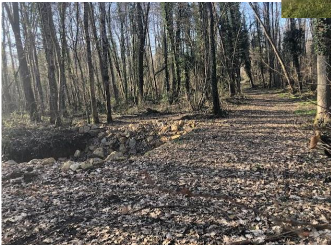
Grâce à un solide enrochement, le chemin de la Basselle est à nouveau carrossable
