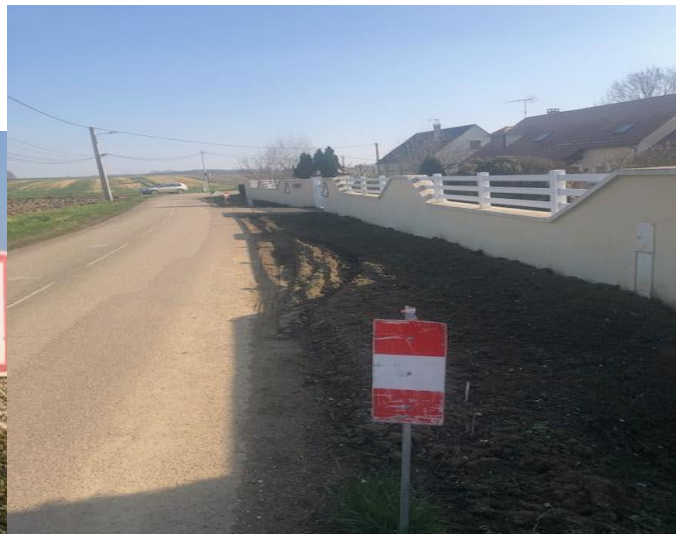
Comblement d'un fossé dangereux à CHICHY
